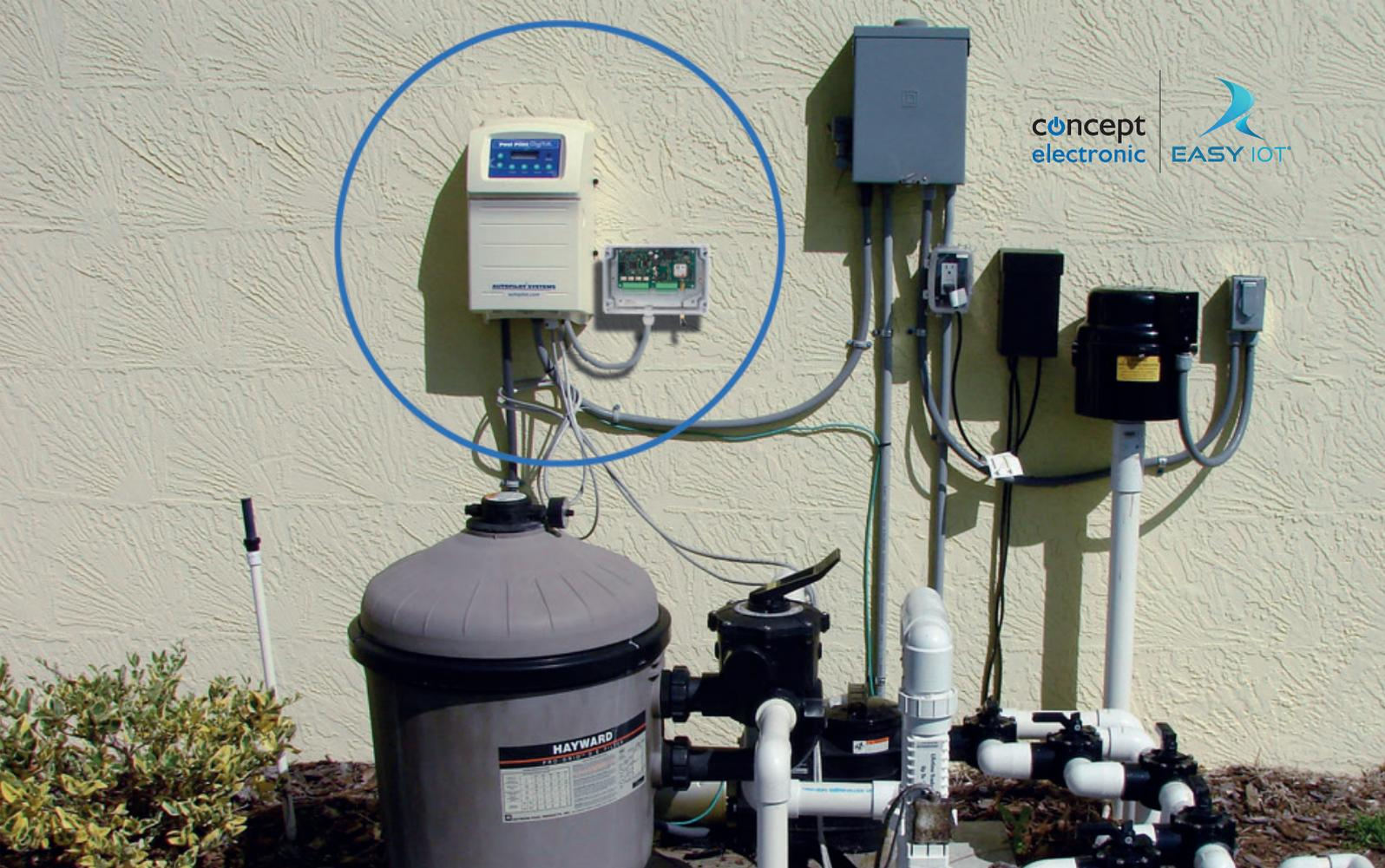
Abbildung zeigt eine Wasseraufbereitungsanlage. EB-REMOTE ist an die Relais der Steuerung angeschlossen. Erfasst werden: Störung Pumpe, Filter voll und Sammelstörung. Über das Dashboard kann die Anlage ausgeschaltet werden.
